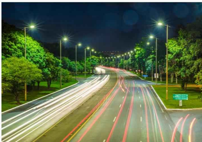
ILUMINAÇÃO LED EIXO RODOVIÁRIO
