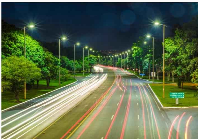
ILUMINAÇÃO LED EIXO RODOVIÁRIO
